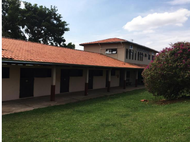
FIGURA 1 - FACHADA DO HOSPITAL VETERINÁRIO EQUICENTER
