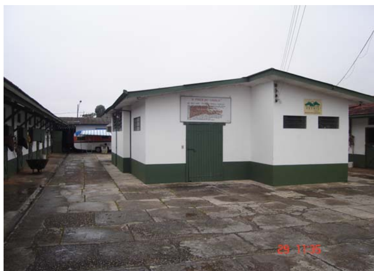
Figura 1 – Instalações do Hospital do Jockey Clube Paraná, ao centro, contendo centro cirúrgico. À esquerda e à direita, estão as cocheiras.
