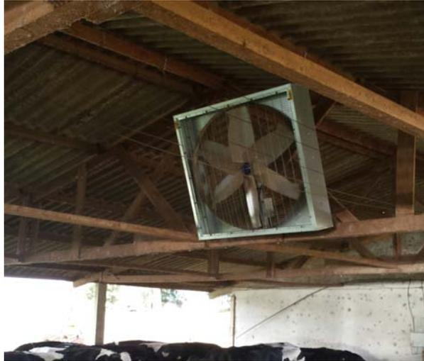
FIGURA 8: Ventiladores, são programados para funcionarem nos horários mais quentes do dia.
