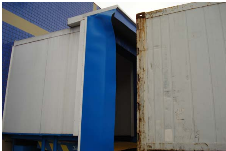
Figura 16. Caminhão frigorífico sendo encostado na DOCA para realização de vistoria
